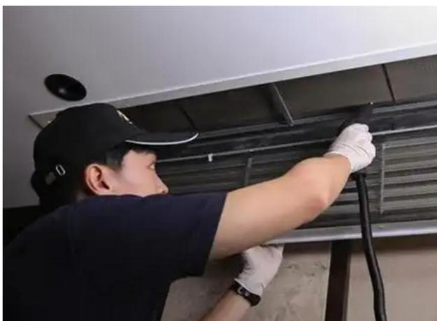
(3) 高效真空集尘系统与风管系统连接、固定，并开启吸尘器。
